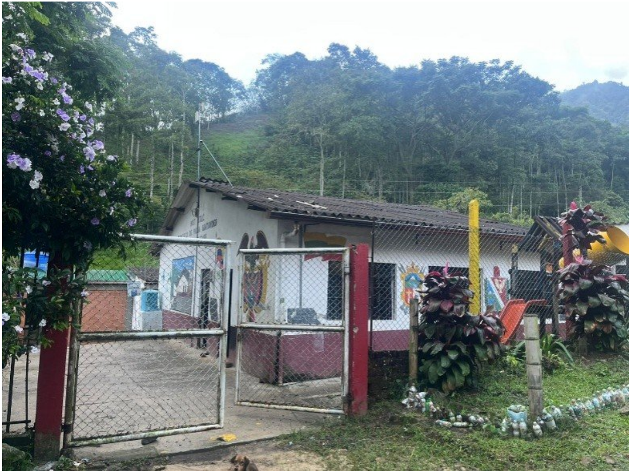
Escuela rural La Villa – zona corregimiento de Ibagué Foto propia (2025)
